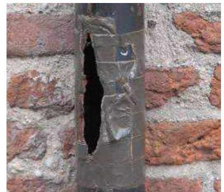
Kapotte delen van de hemelwaterafvoer met hetzelfde materiaal vervangen: vergunningvrij
