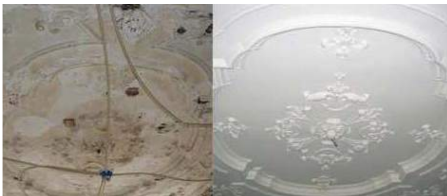
Geen onderhoud, maar restauratie. Vergunning nodig.
