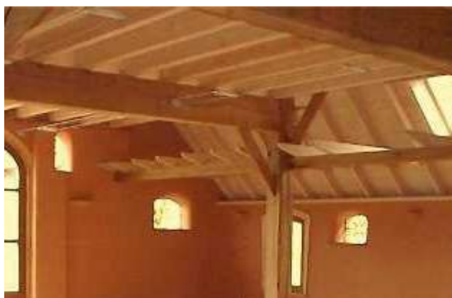
Aanbrengen binnenisolatie. Vergunning nodig.
